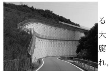
図 1 補強土壁(帯鋼補強土壁)
