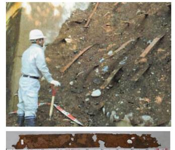
図 2 補強材の腐食による崩壊(上) 帯鋼補強材の孔食の状況(下)
